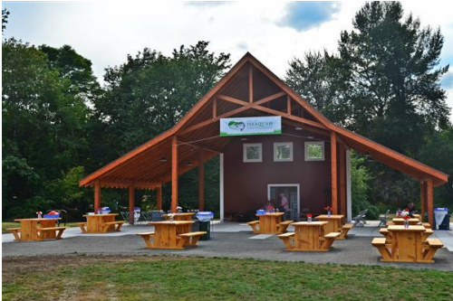
CONFLUENCE PARK 655 RAINIER BLVD N
